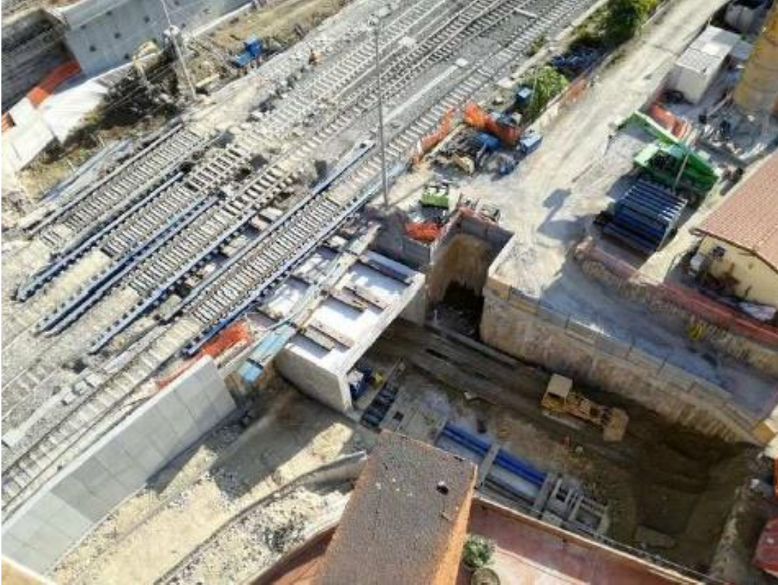
Esempio di scatolare a spinta e sistema ponte Essen
